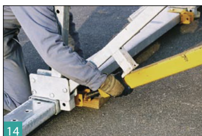
14 Reposer l'ensemble avec un calage de 10 cm mini sous le U bas afin de brocher les bracons de reprise après réglage.
