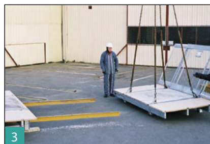
3 Relever l'auvent de la plate-forme REMAT et le brocher. Élinguer la plate-forme.
