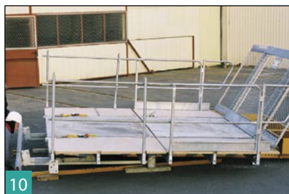
10 Amener les bracons de reprises sous la plate-forme par l'avant.
