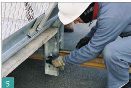
5 Brocher la REMAT sur les coulisses arrières de la PRM.
