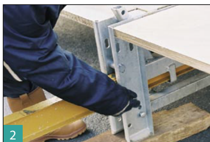
2 Brocher les coulisses sur la console arrière de la PRM.
